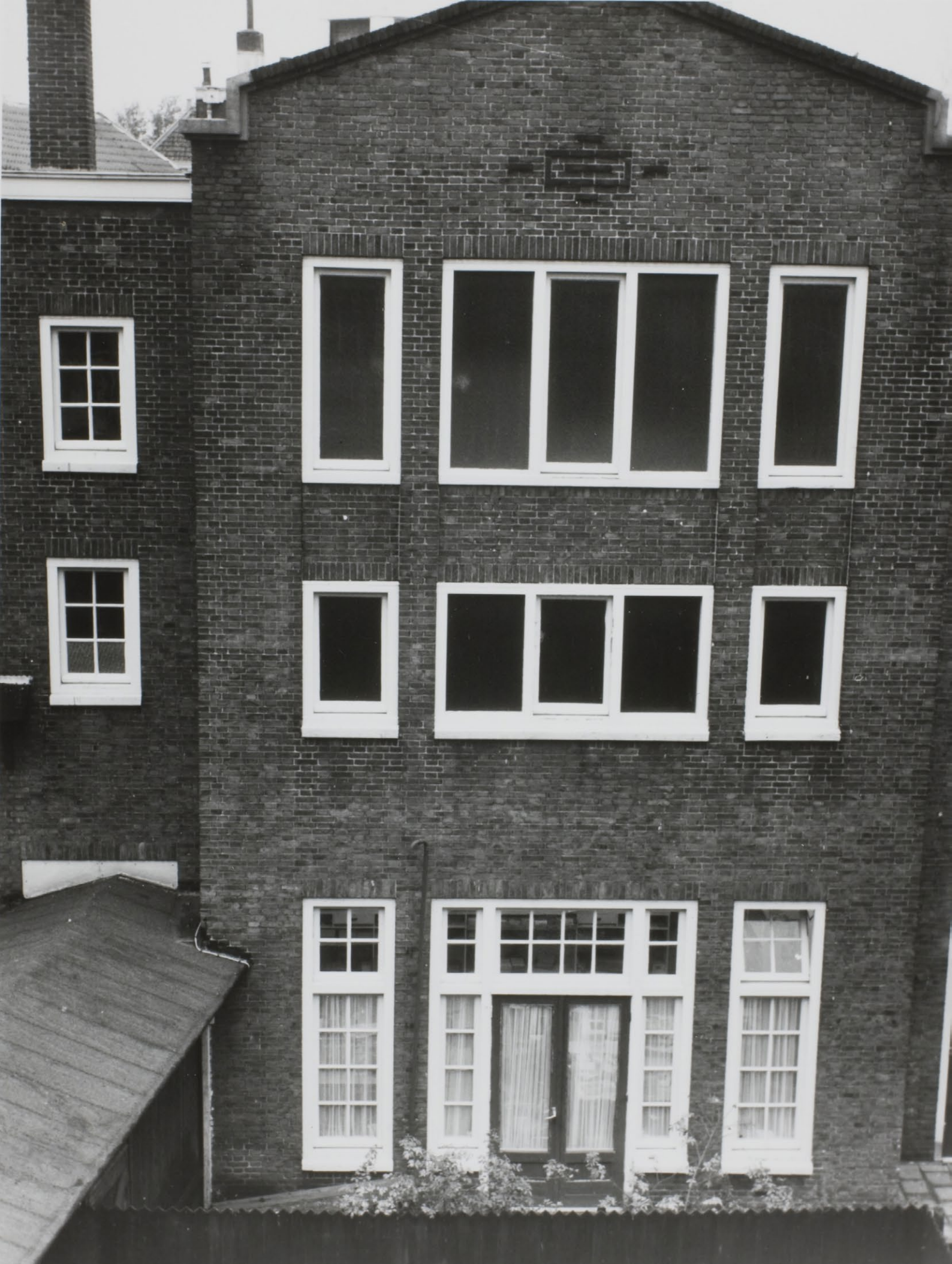
De achtergevel van het pand aan Oude Vest 45 met op de verdiepingen de kapel. Bron: ELO; PV_PV28940.1
