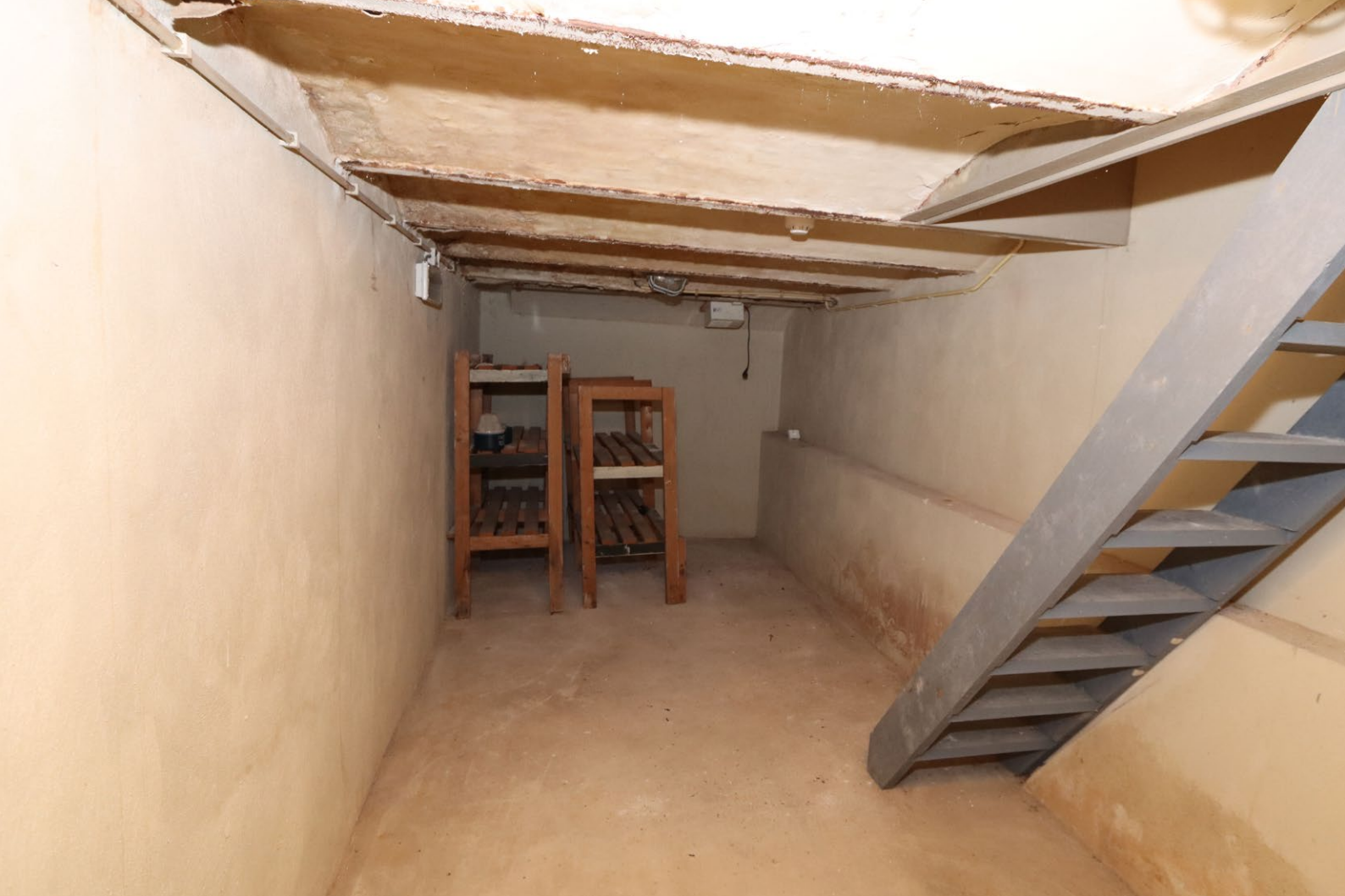
AFBEELDING: De kelder met de troggewelven
