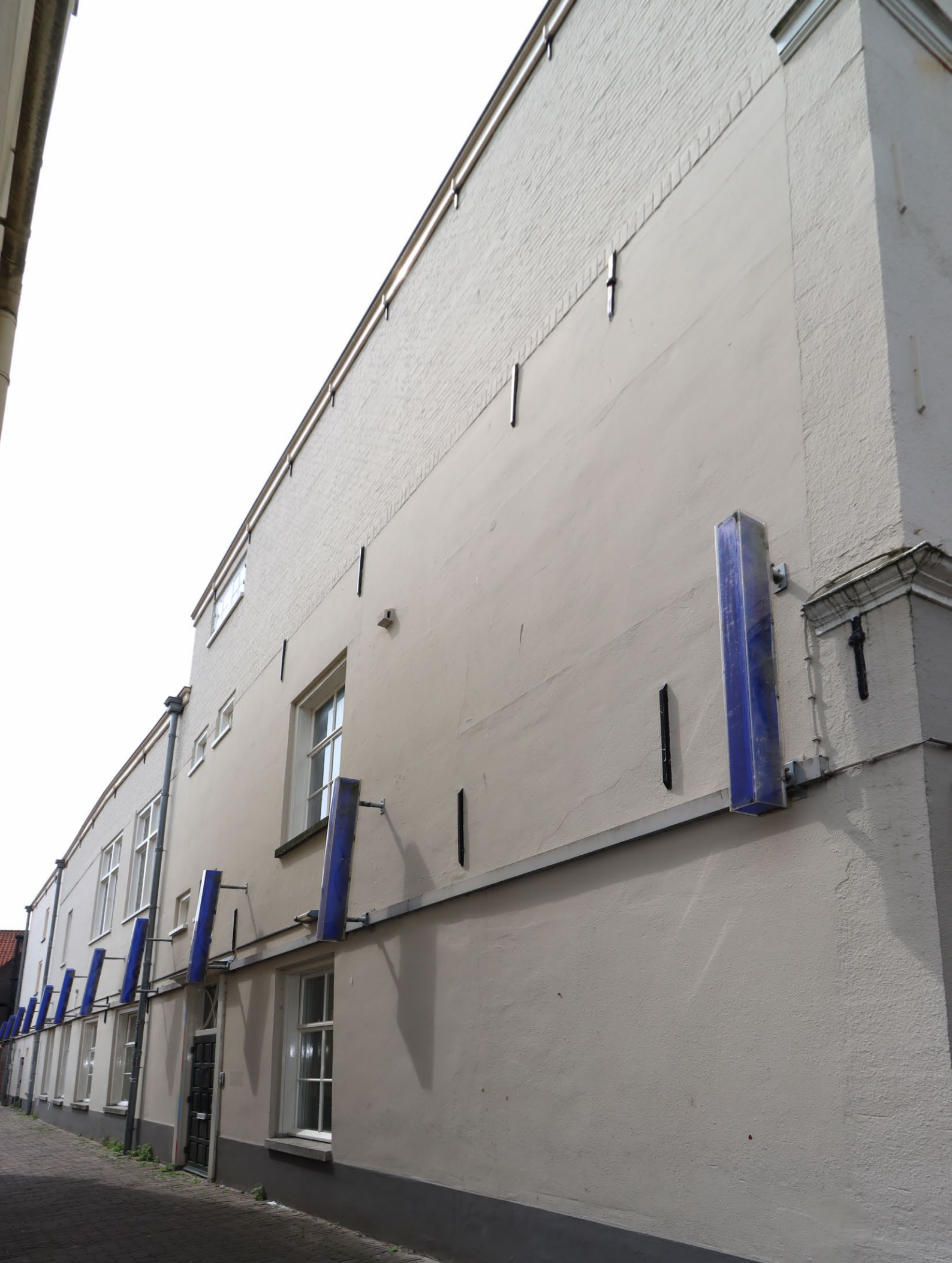
De oostgevel in de steeg vanaf de Oude Vest gezien
